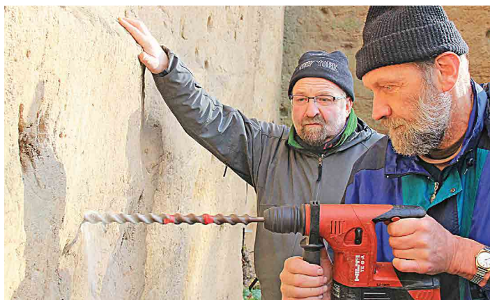
Správci skal instalovali jisticí kruh a borhák v Debři. Foto: Jiří Říha
