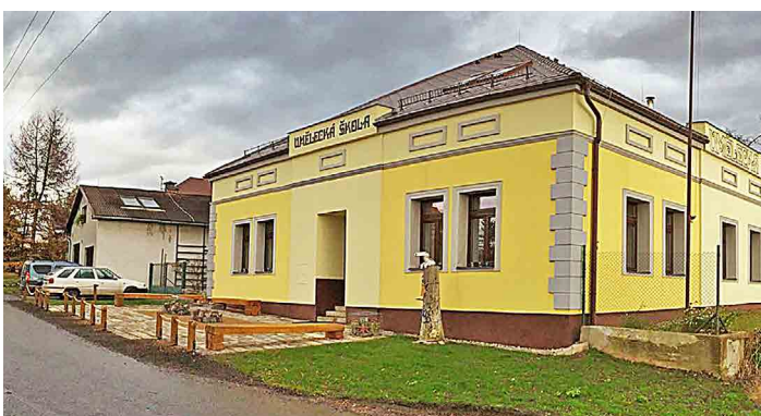
Předprostor ZUŠ Mšeno po dokončení. Foto: Martin Homola
